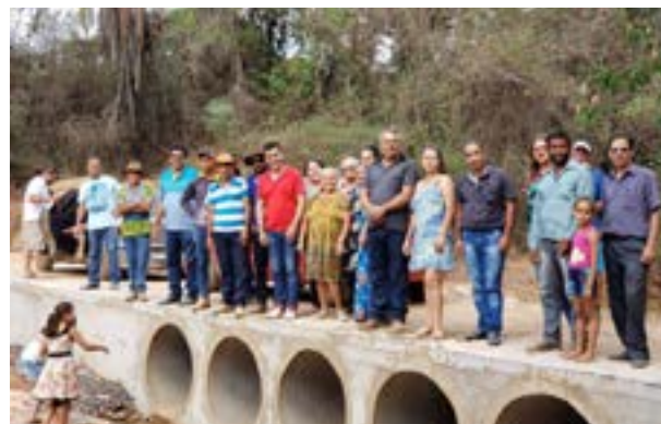
Infraestrutura - Inauguração da ponte sobre o Rio São Lamberto, na Comunidade das Abóboras
