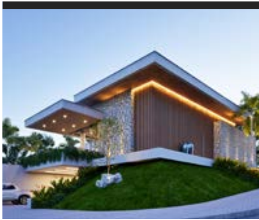
Residência AJ projetada pelo escritório Robson Veloso Arquitetura
