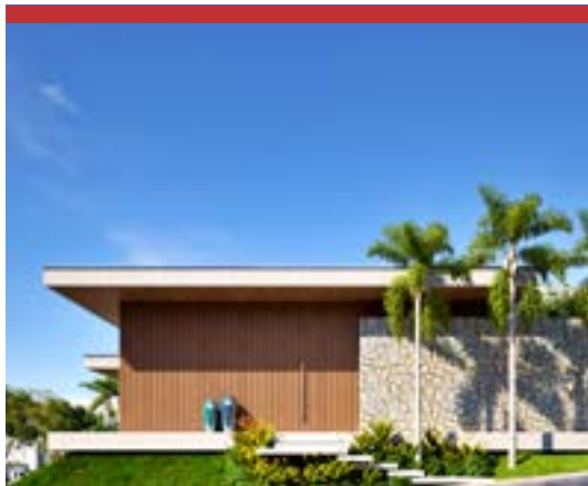
Residência AJ projetada pelo escritório Robson Veloso Arquitetura
